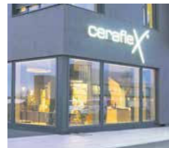
Großkeramik im Außenbereich
