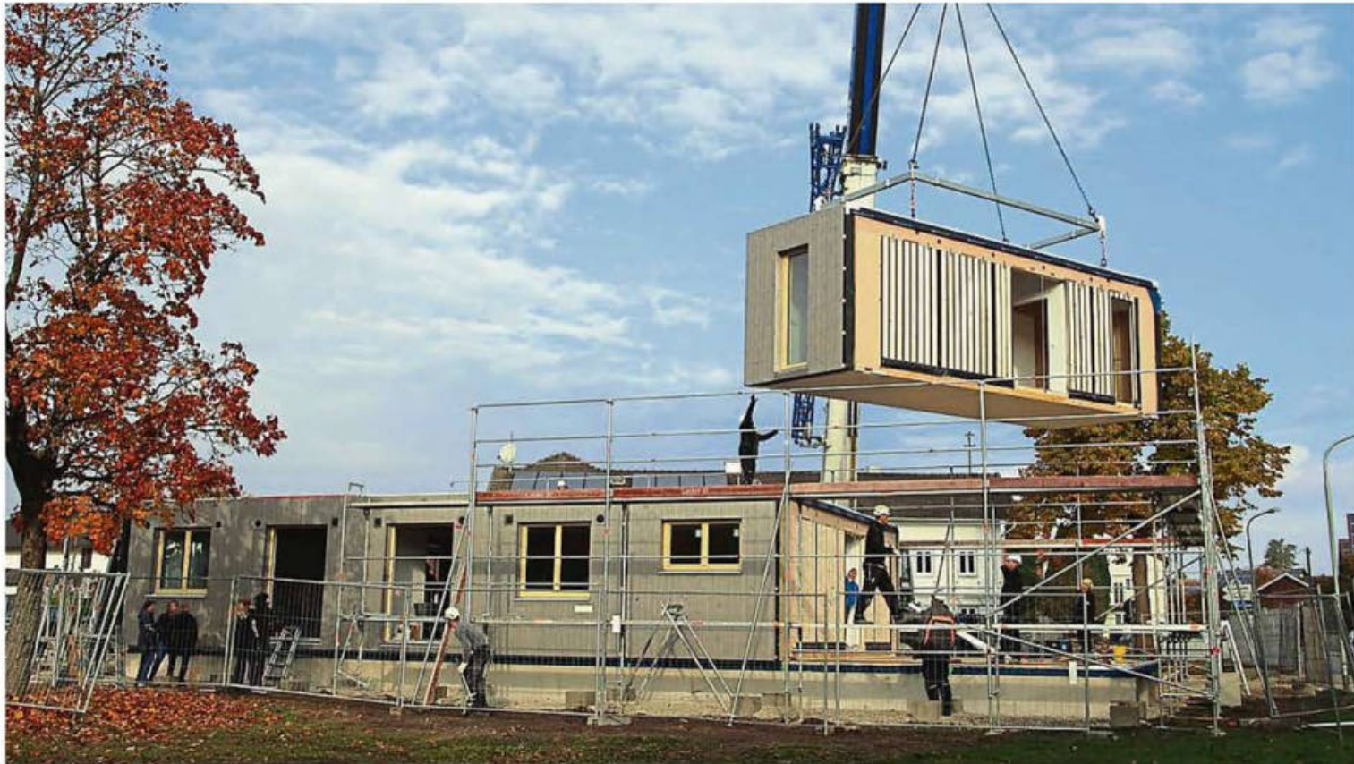
Aus sieben Modulen besteht der neue Kindergarten in Lengdorf. Seit Dienstag werden sie montiert.
