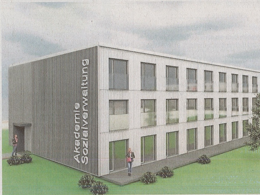
Das geplante Unterrichtsgebäude, das aus Modulen besteht, die nur wenige Hundert Meter nebeneinander produziert werden.
